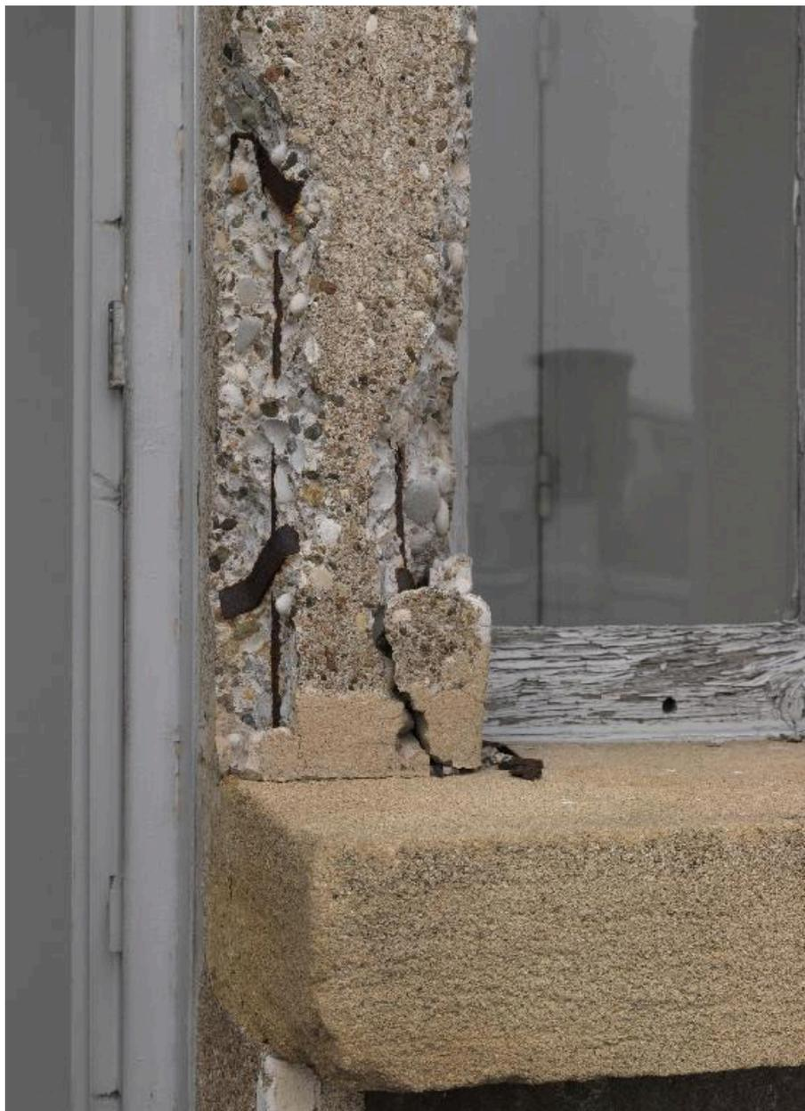
Le pavillon H en 2014 : détail de béton armé dégradé sur la terrasse
