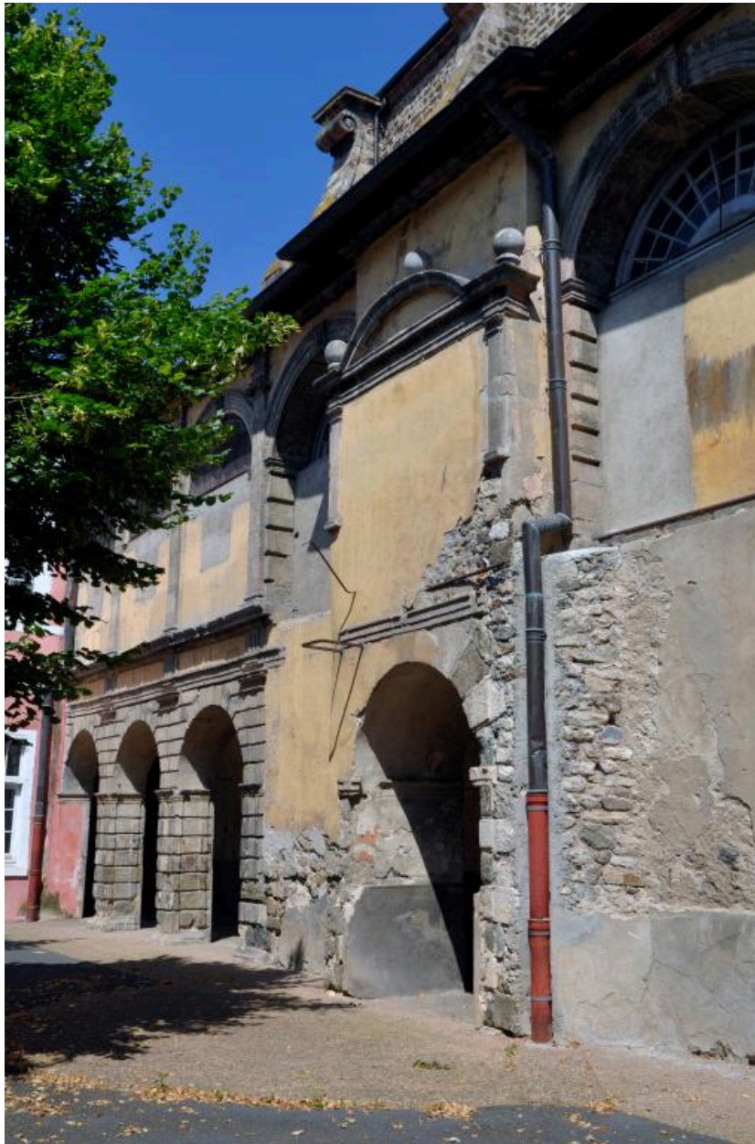
Galerie B : élévation, partie centrale depuis l'est
