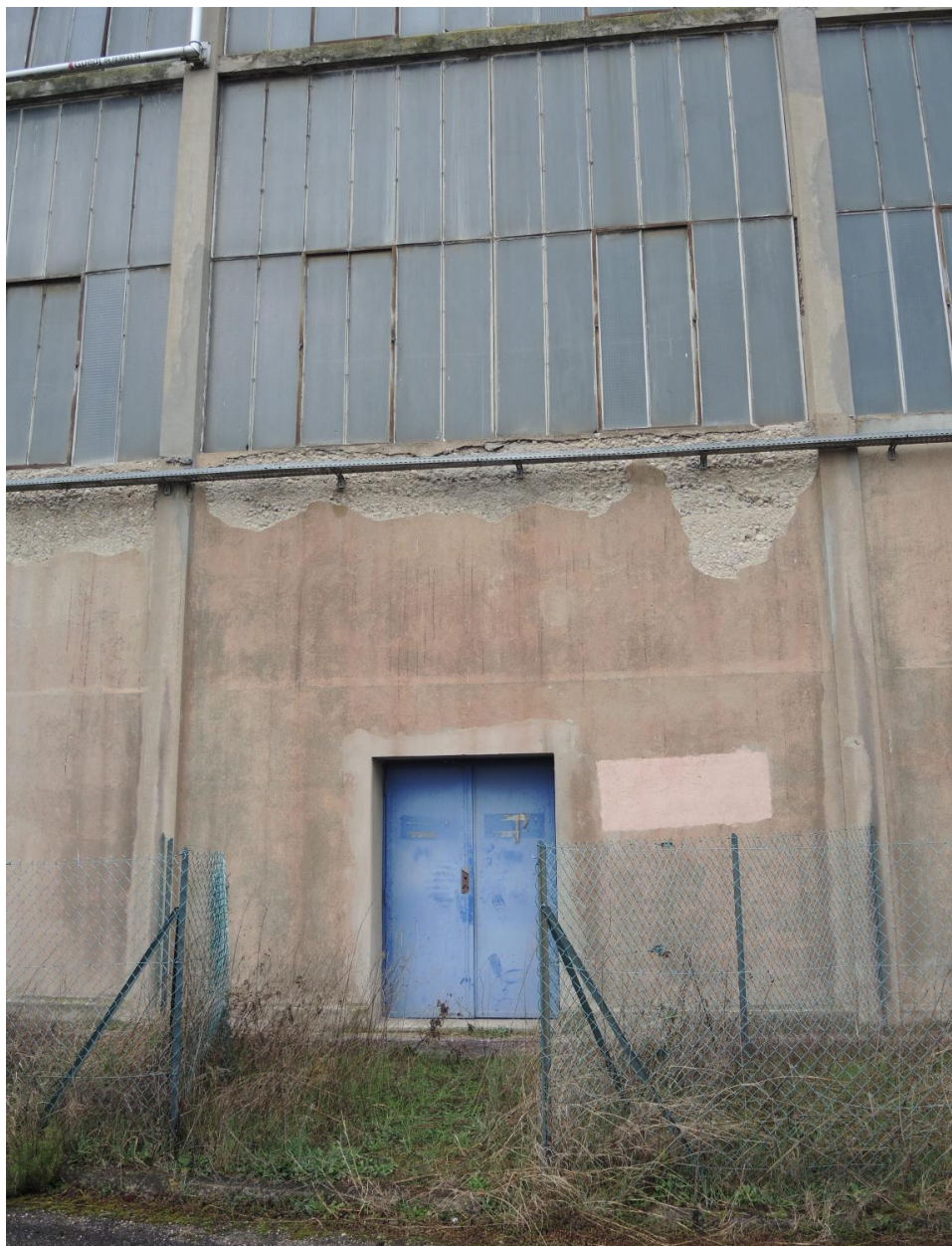
Hangar VI photo vue d'une façade d'extérieure
