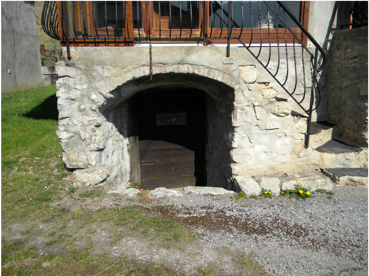
Vue d'une loge sous l'escalier d'un cellier en pignon sud-ouest.
