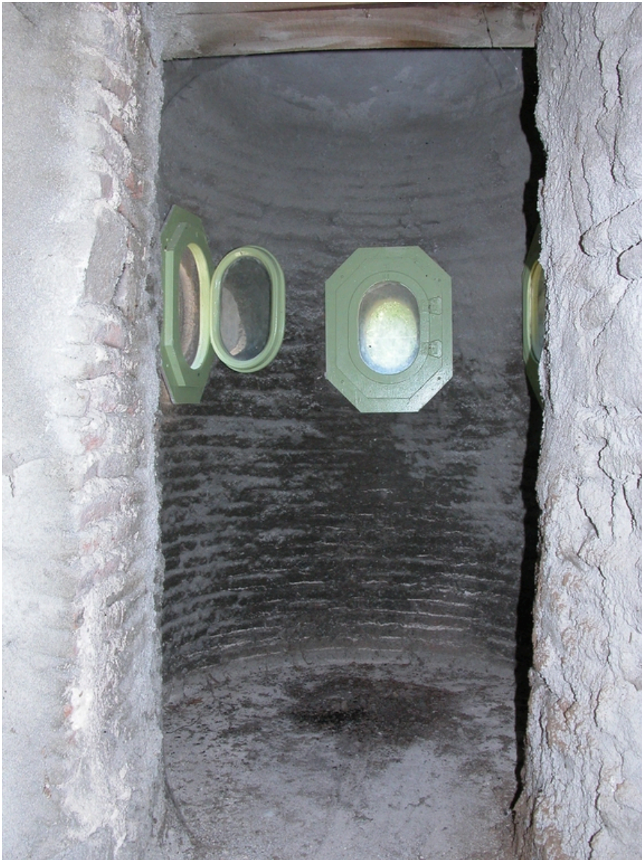
Vue intérieure d'une tourelle en surplomb.
