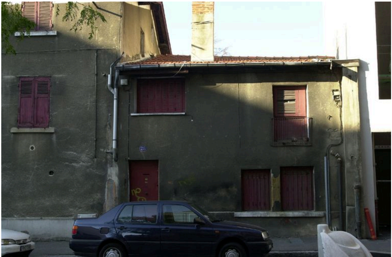
Elévation sur rue du corps de bâtiment nord
