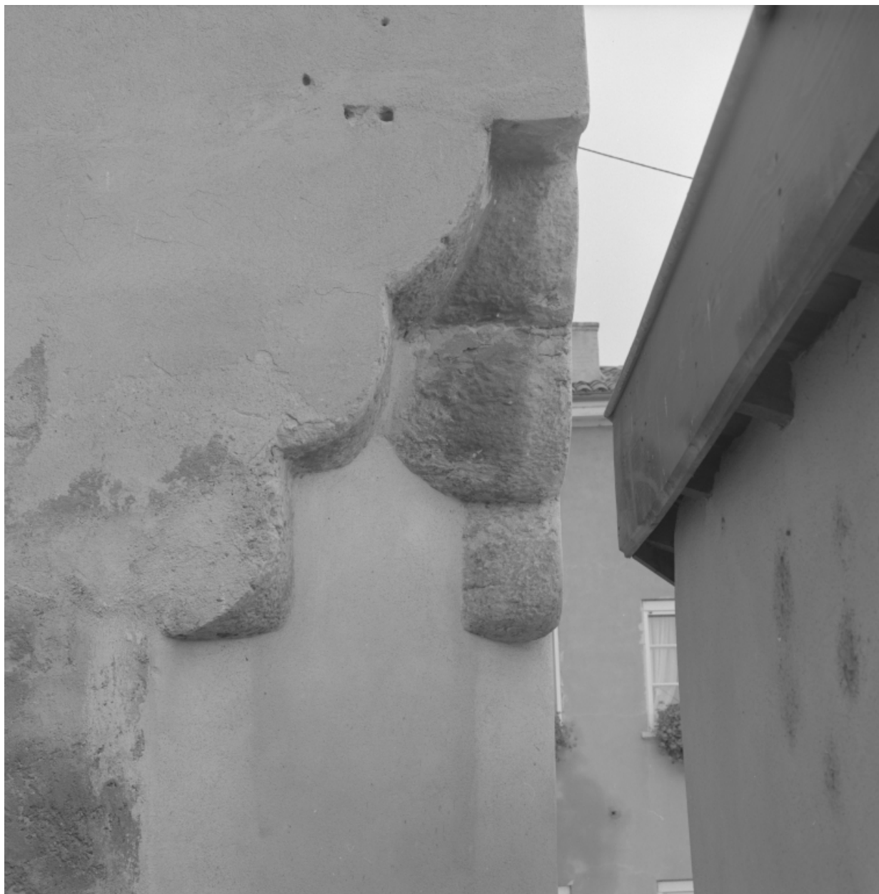
Elévation sur cour, détail : encorbellement.
