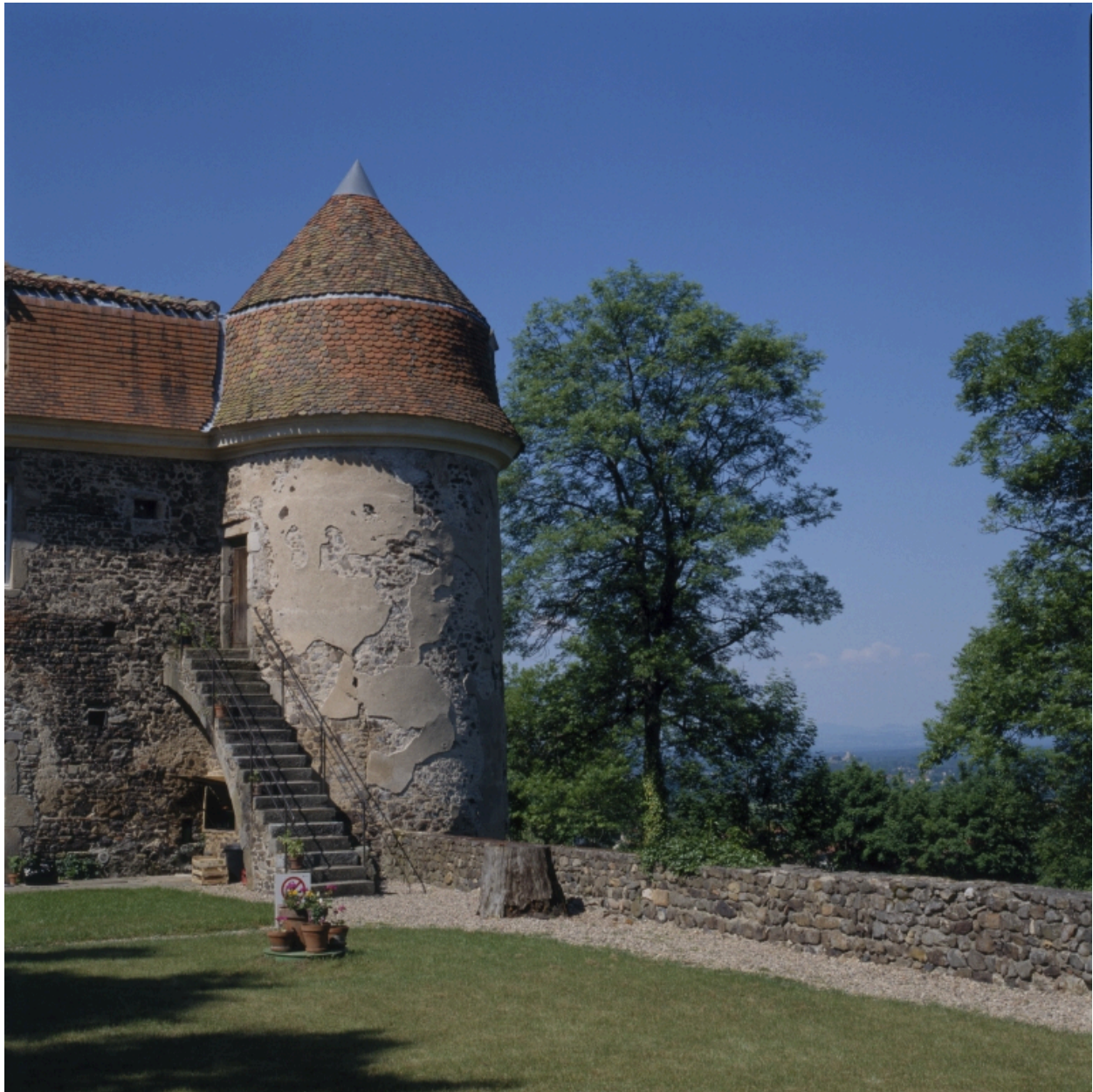
Vue de la tour nord du logis côté cour de service, de l'ouest.
