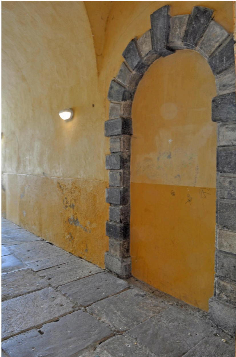
Bâtiment E : baie murée avant 1862
