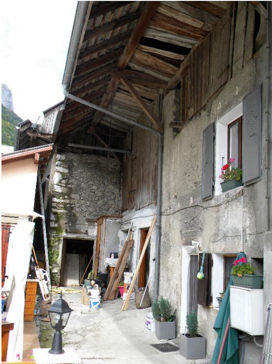
Façade principale d'une ancienne ferme (2008 C3 310).
