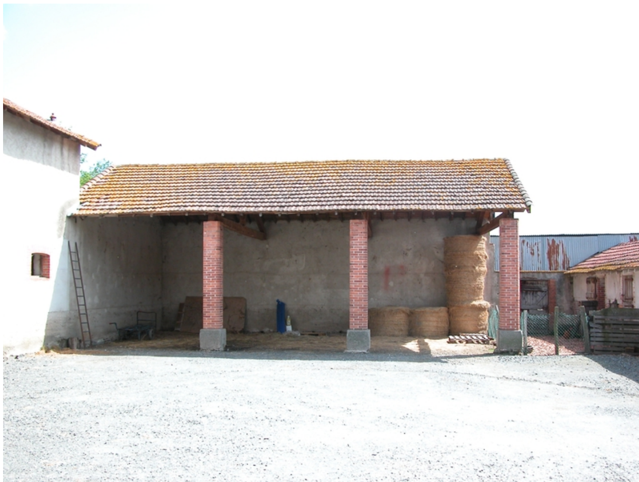
Vue d'ensemble du hangar-remise.
