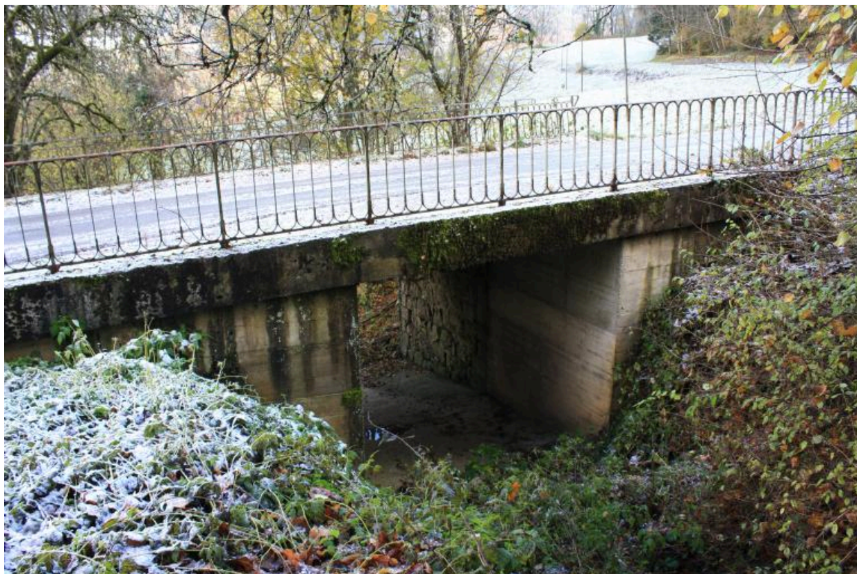
Le vieux pont de Trélachaud, face amont
