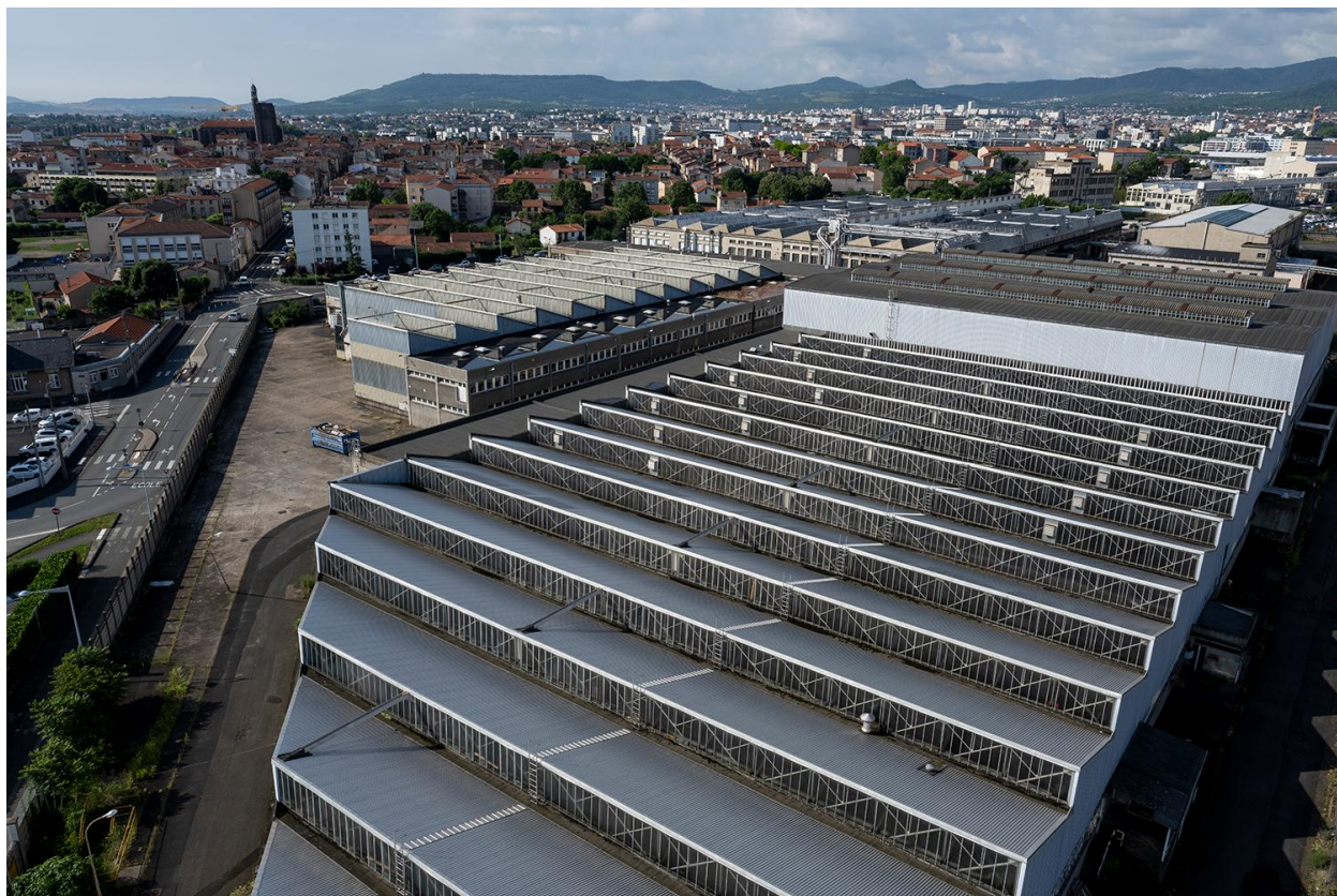
Vue aérienne d'une partie des ateliers (O26, V22,...) dans le quartier des pistes d'essais.
