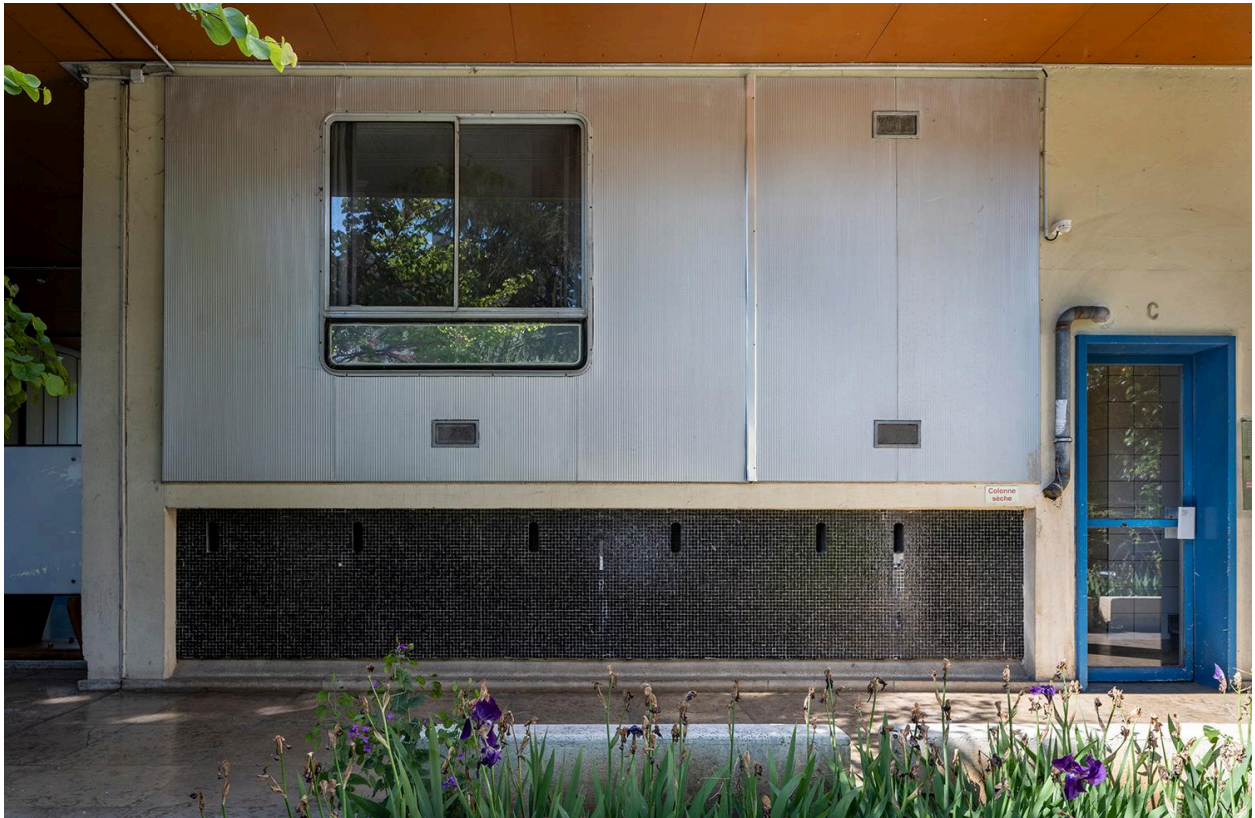
Façade sud, loge du gardien au rez-de-chaussée (1 baie)
