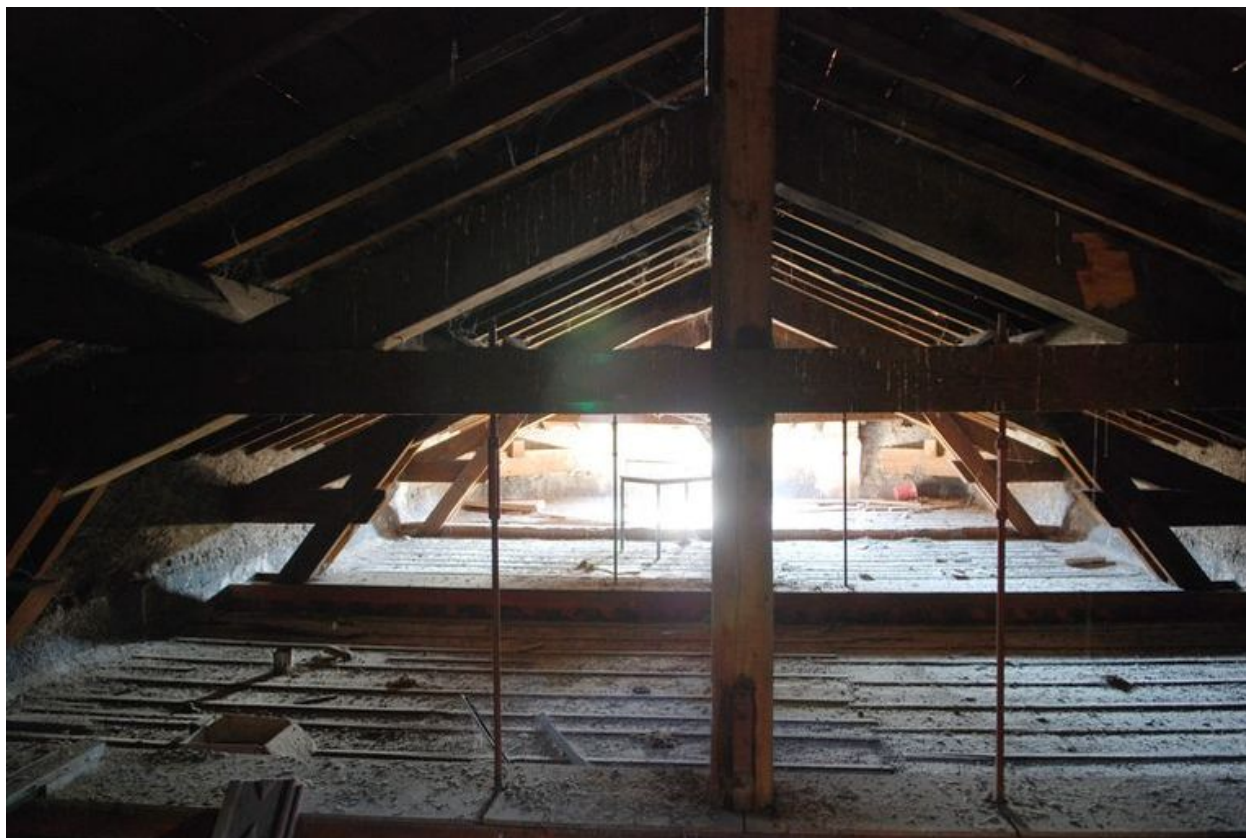
Charpente de l'avant-corps central du bâtiment 505
