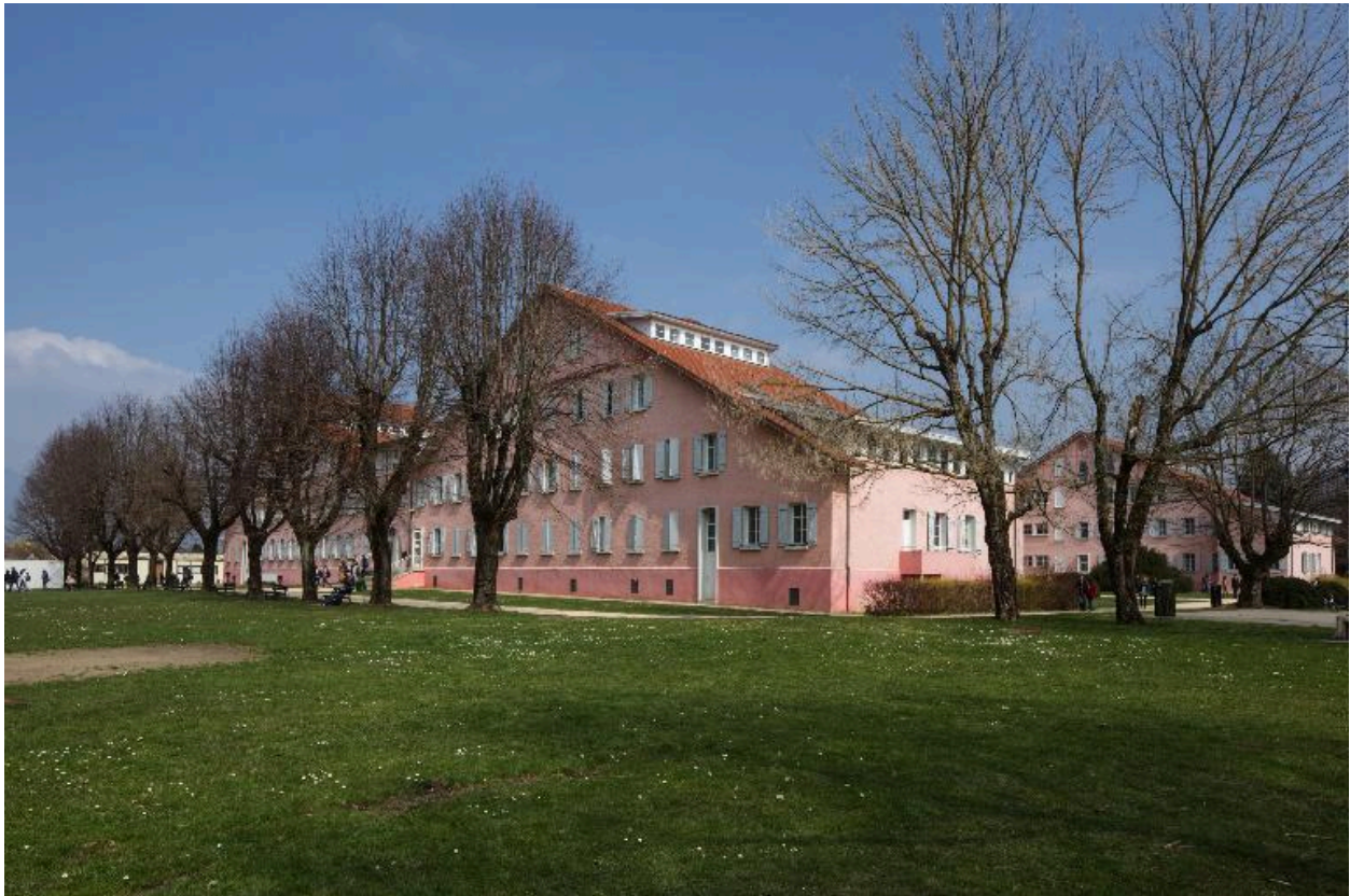
Bât. A : vue depuis le sud-ouest
