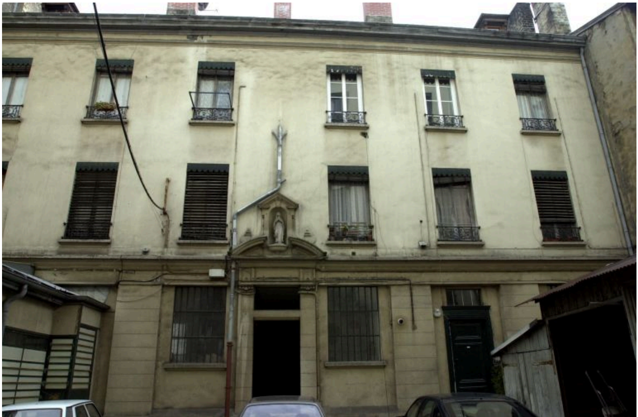
Elévation principale de l'immeuble sur cour
