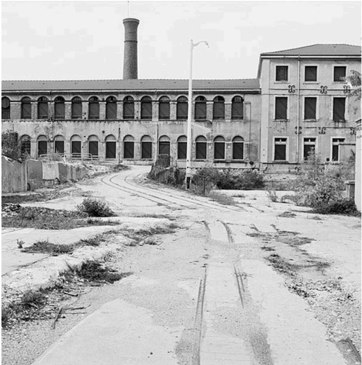
Vue est du bâtiment principal
