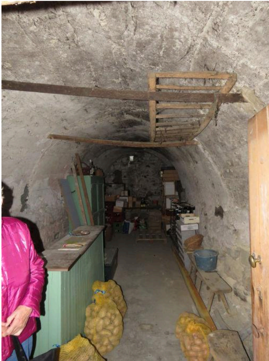
Vue intérieure : sous-sol ayant probablement servi de chai
