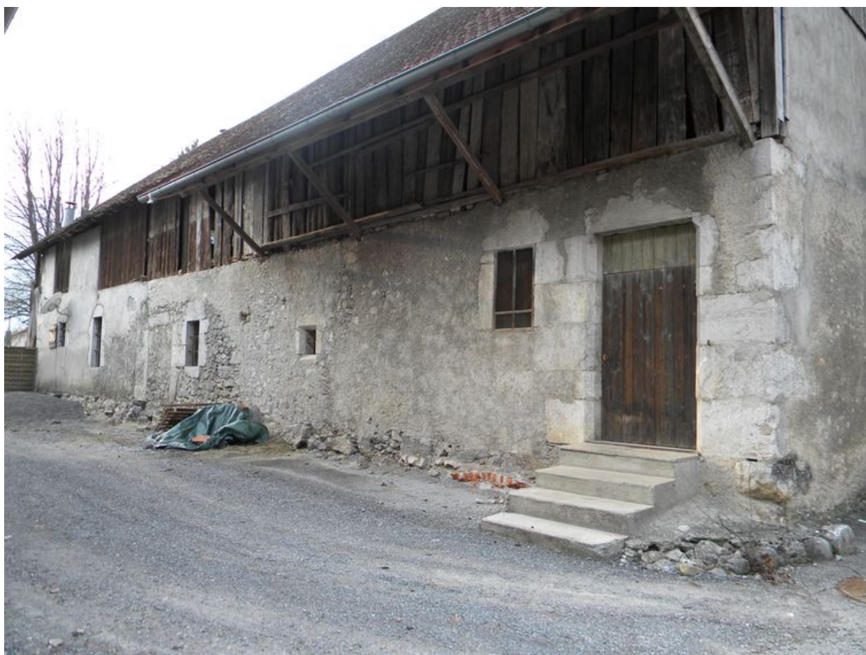
Vue de la façade arrière de la dépendance agricole sud.
