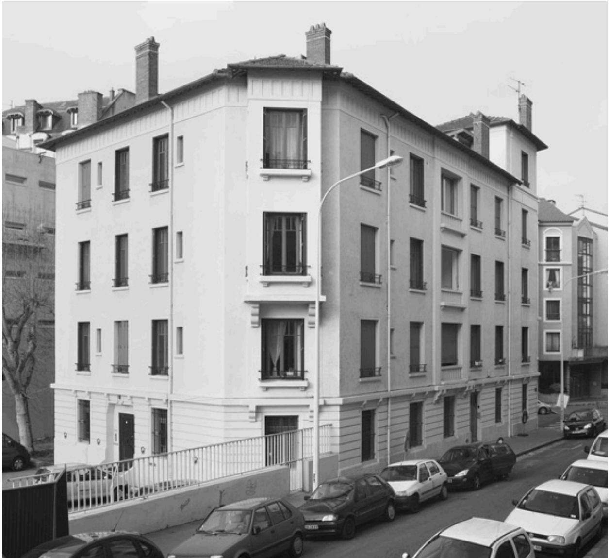
Vue sud de l'immeuble patronal
