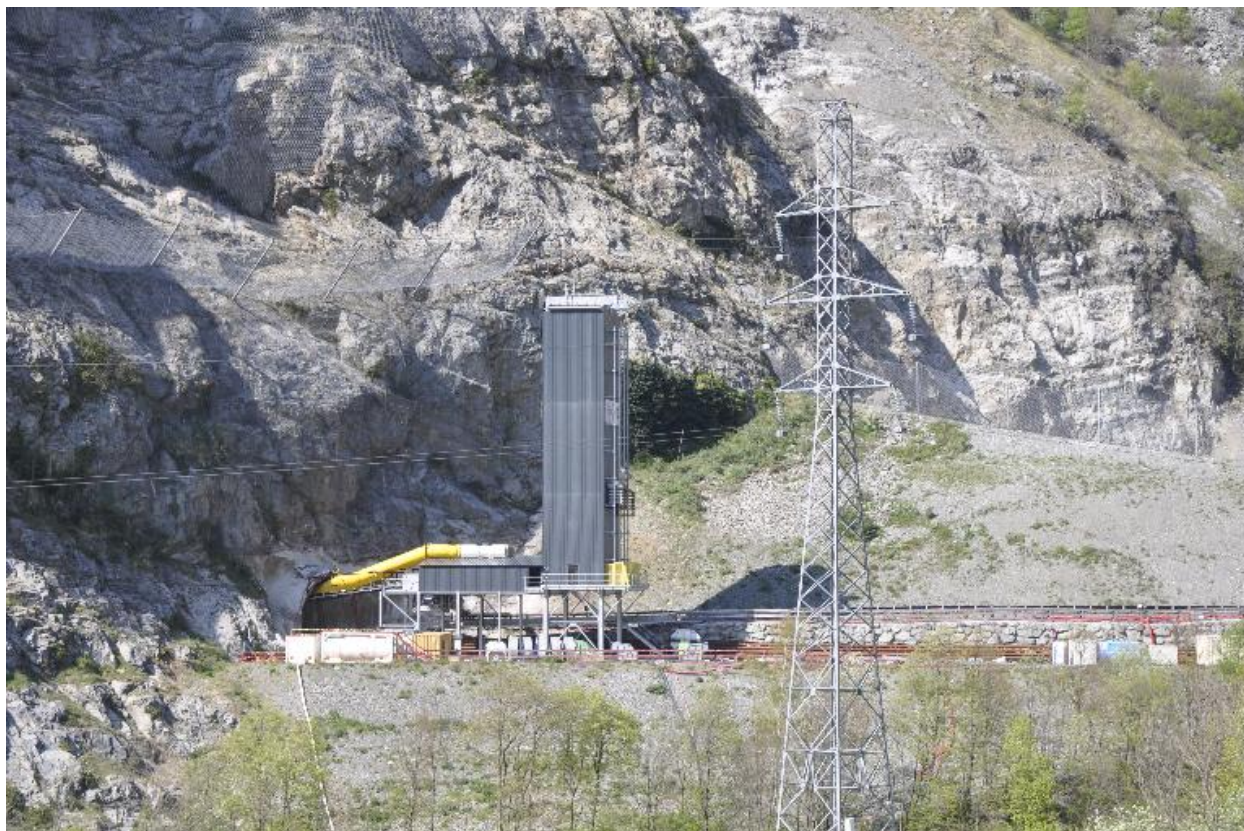
Vue de la construction de la nouvelle centrale
