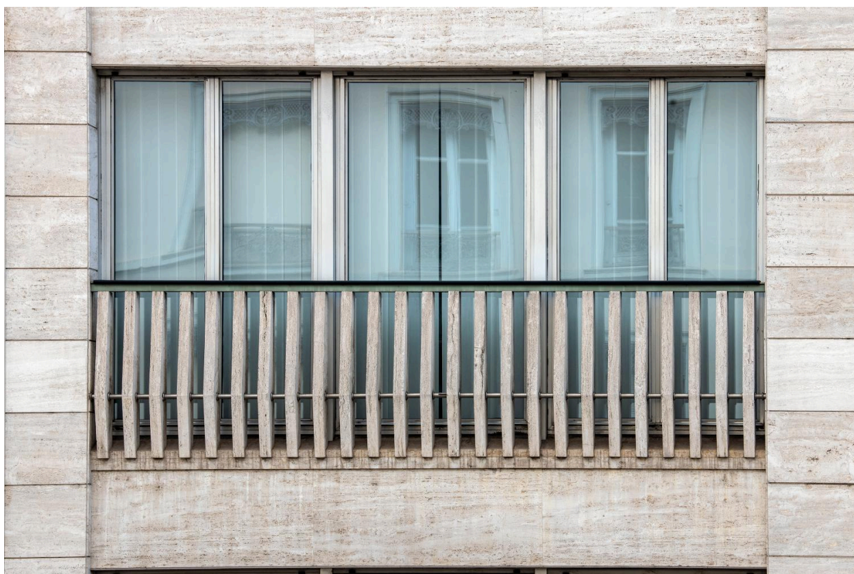
Travée située au-dessus de l'entrée 18 rue Childebert : garde-corps
