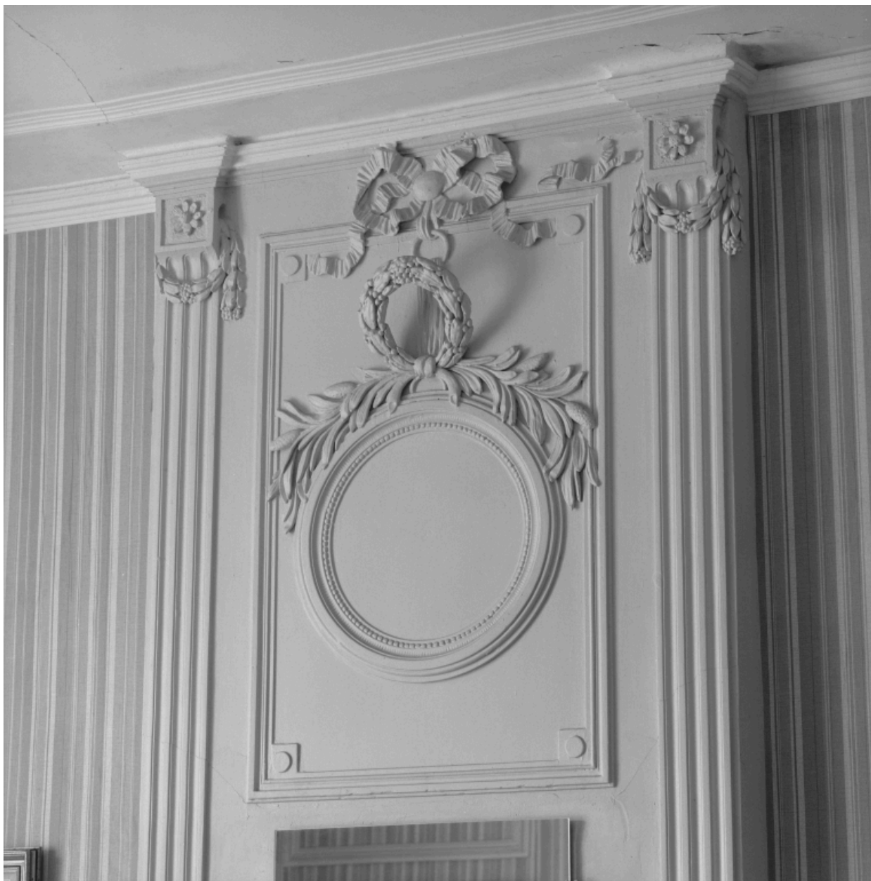
Détail du trumeau de la cheminée.
