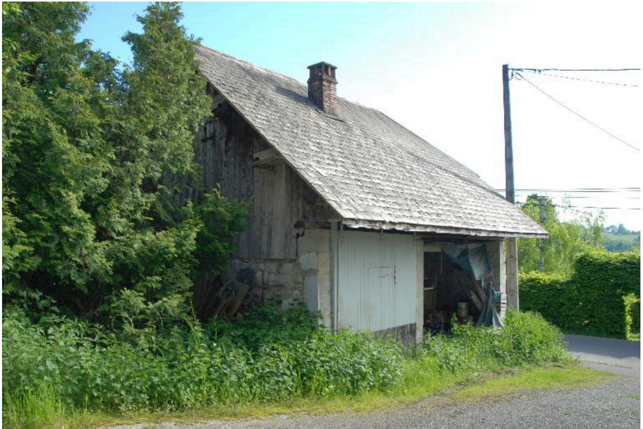
Vue du pressoir et du garage.
