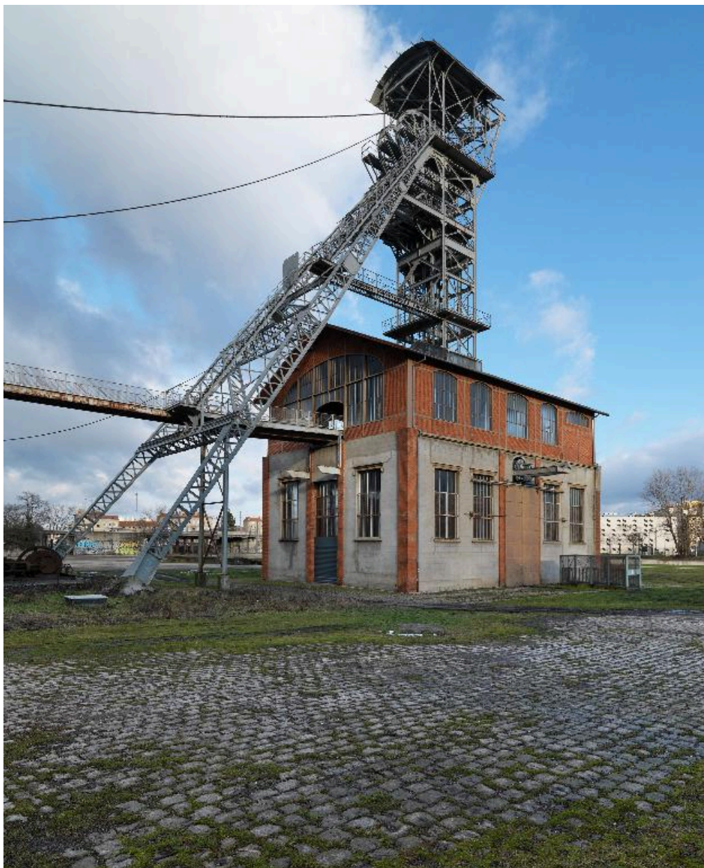
Vue ouest du chevalement
