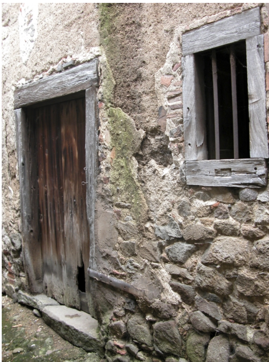
Îlot 2. Saint-Jean (rue) 28, 30. Traversière entre les deux maisons, détail des baies du rez-de-chaussée de la parcelle 684.
