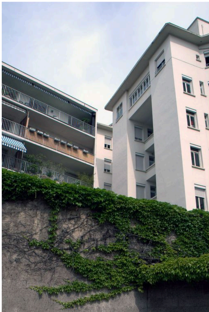
Elévation postérieure, détail du corps de bâtiment est
