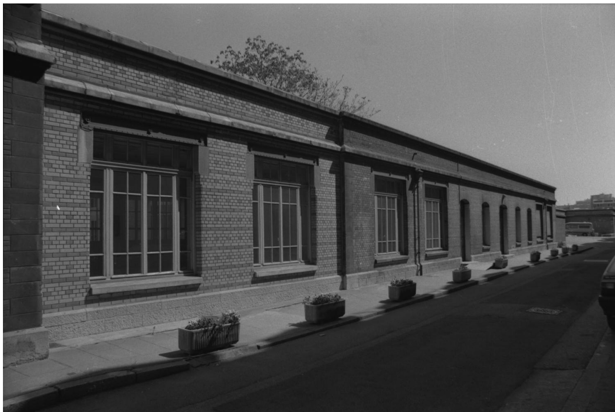
Bâtiments J (bureaux) et K (crèche), façade ouest
