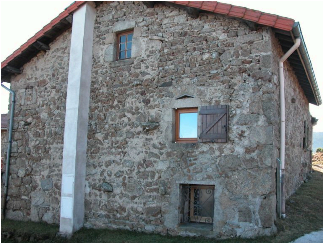
Elévation nord du logis de la ferme.
