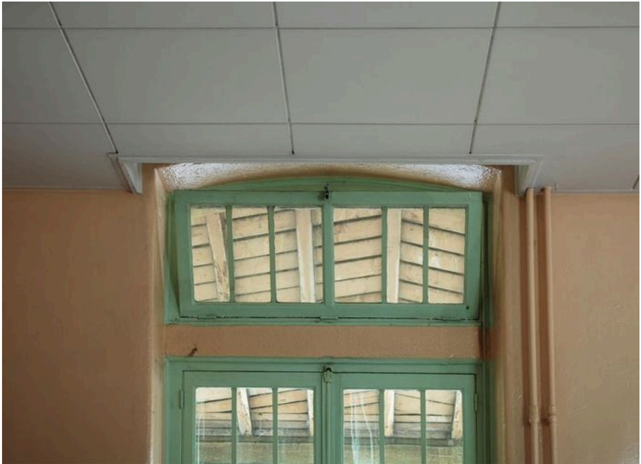
Rez-de-chaussée : détail du système d'ouvertures
