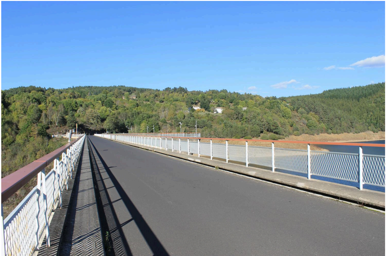
Neuvéglise-sur-Truyère - Fridefont, barrage de Grandval, la route sur la crête du barrage vue depuis le sud.
