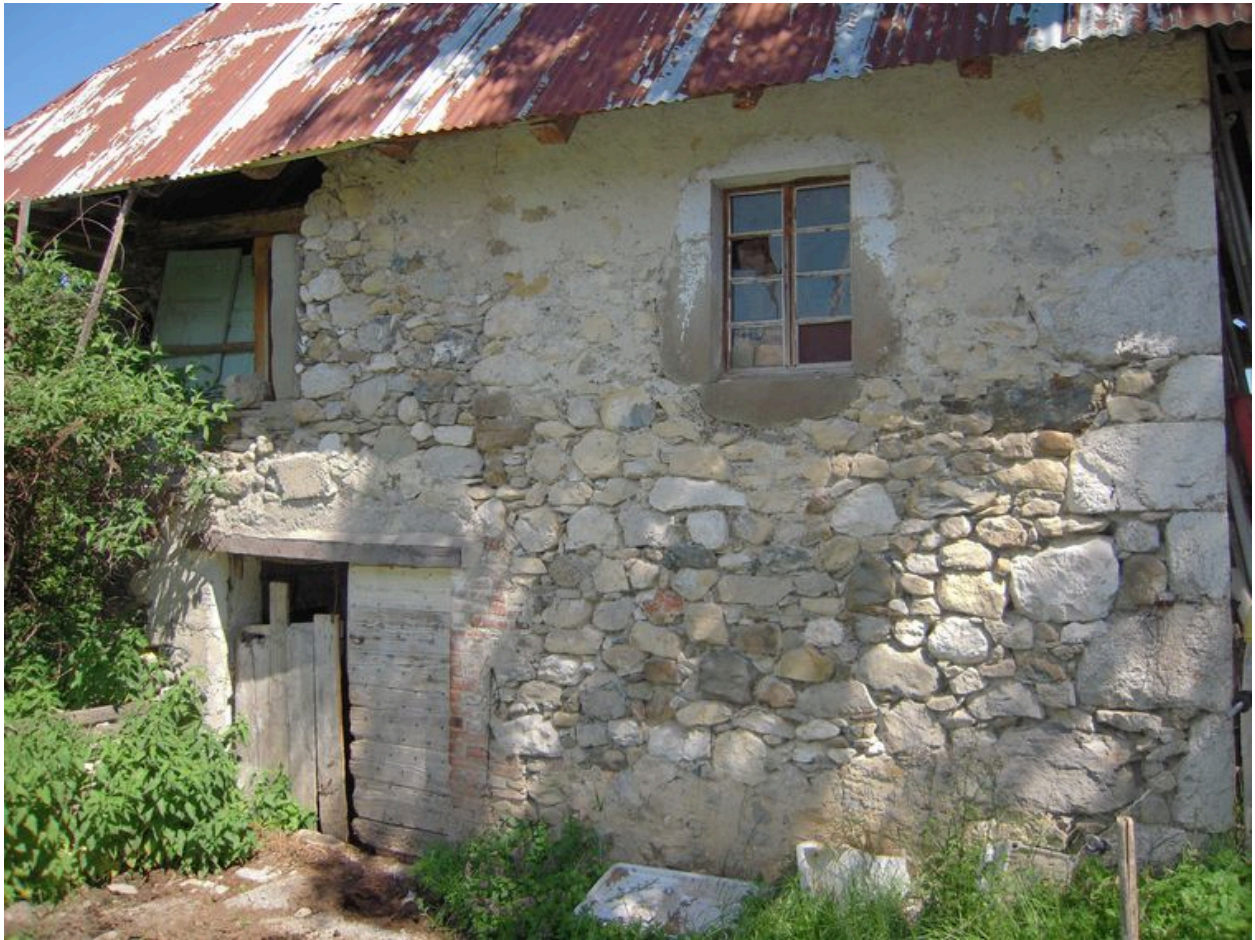
Vue sur les ouvertures de la façade sud.
