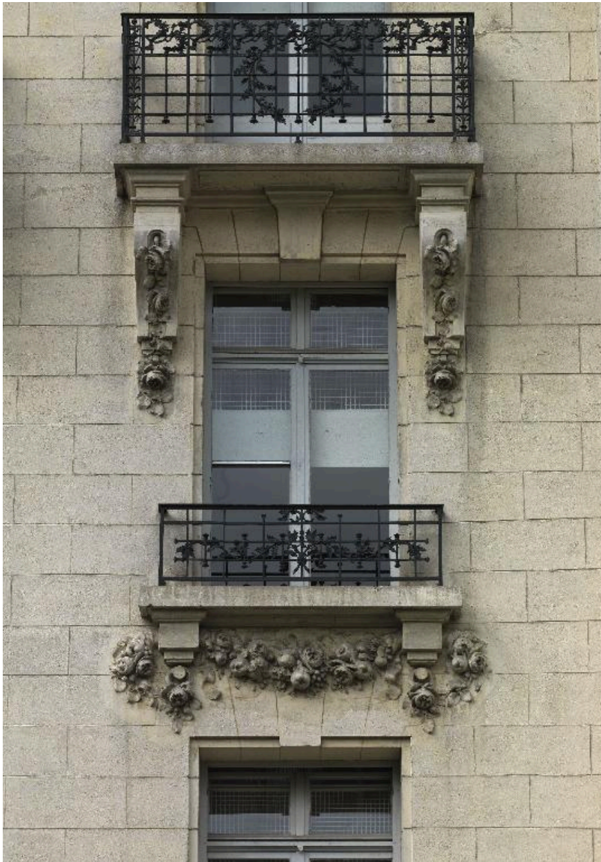
Façade sur cour: baie du 2nd étage
