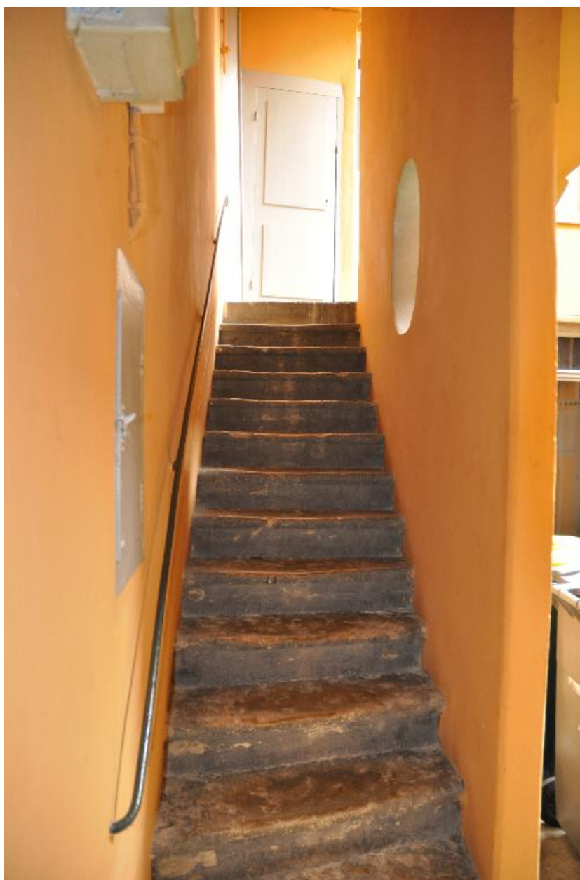
Vue de la première volée de l'escalier
