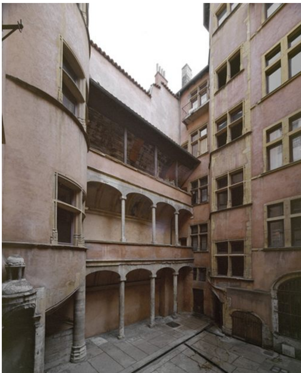
La cour : cage d'escalier ouest, galerie de liaison et corps de bâtiment est
