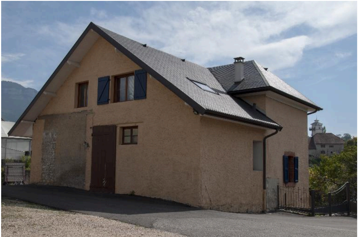
Vue de trois-quart depuis le nord-ouest, façade postérieure
