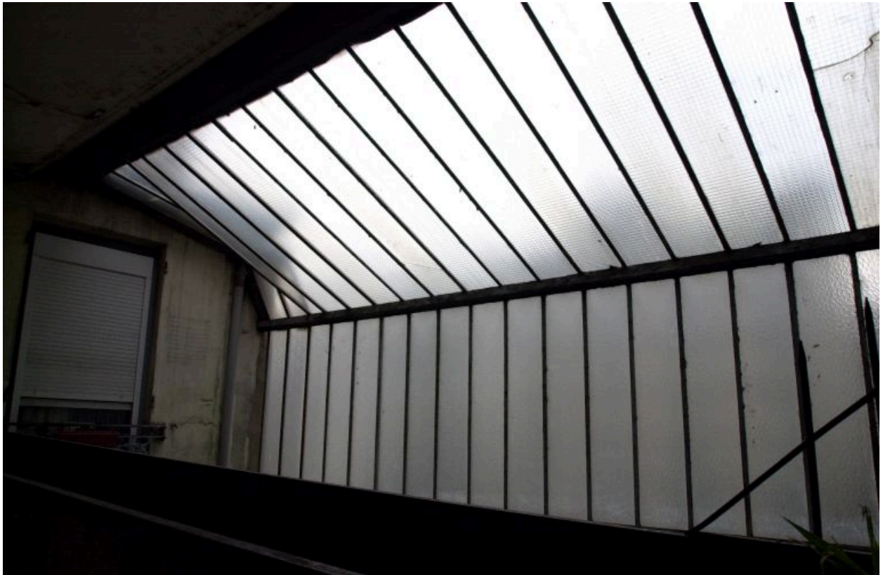
Détail de la verrière au-dessus de la cour
