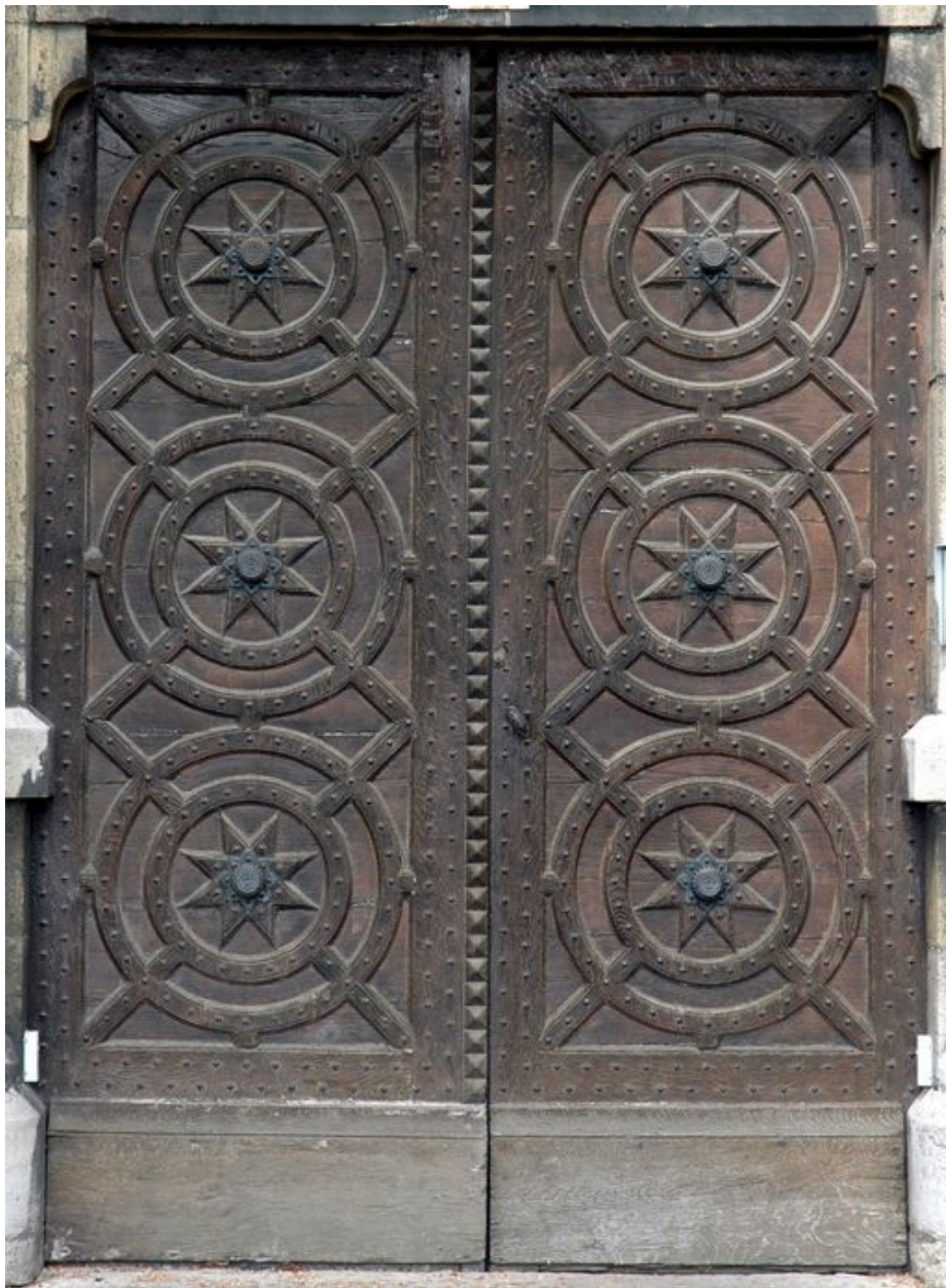
Elévation principale, porte, détail des vantaux
