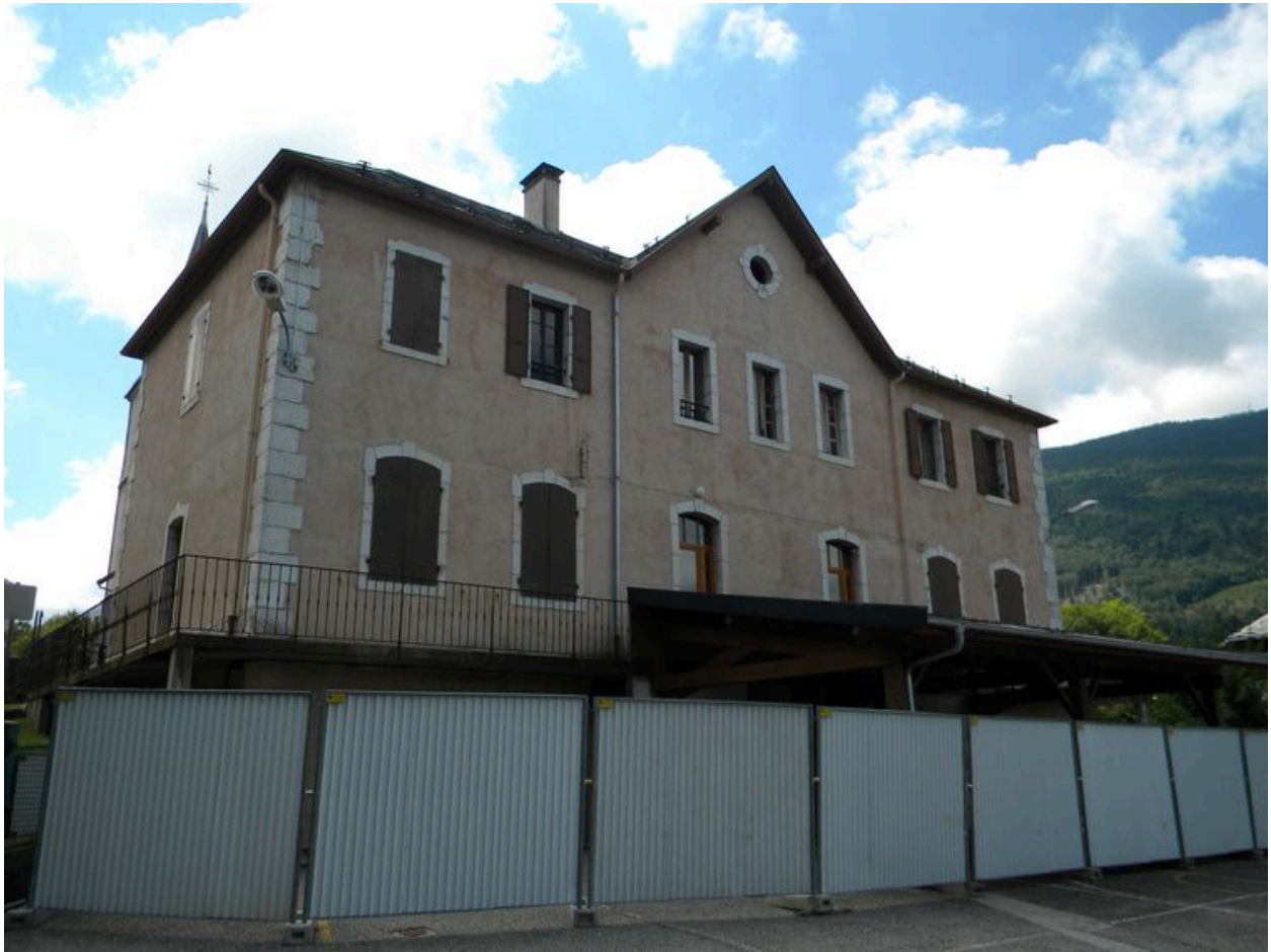
Vue d'ensemble de la façade nord.
