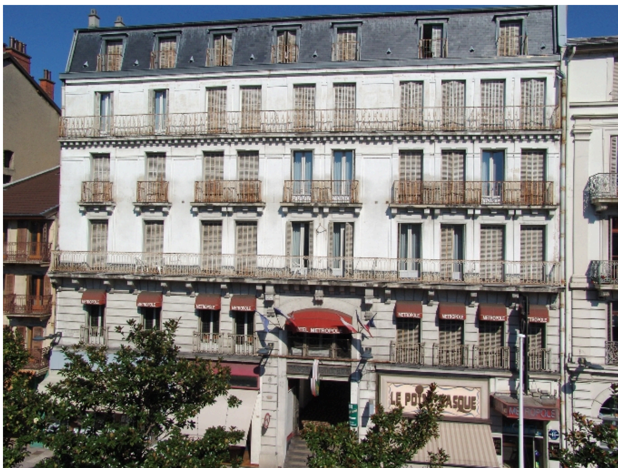
Façade sur la rue du Casino
