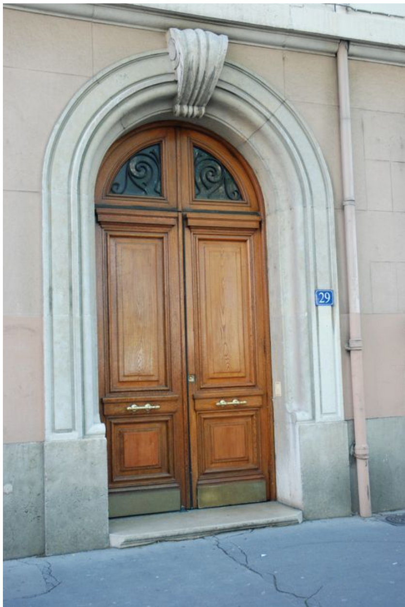
Détail de la porte d'entrée (rue Cavenne)
