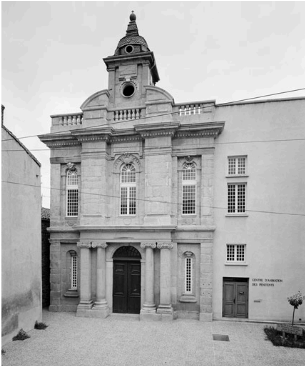
Façade, vue d'ensemble.
