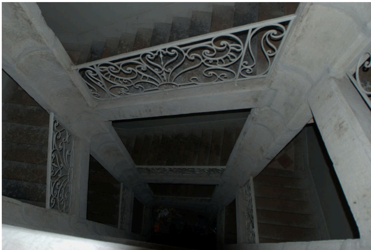
Escalier de l'immeuble XVIIIe
