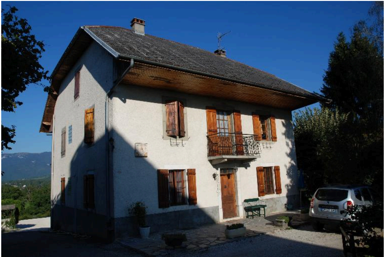
Vue d'ensemble de l'habitation (façade principale).
