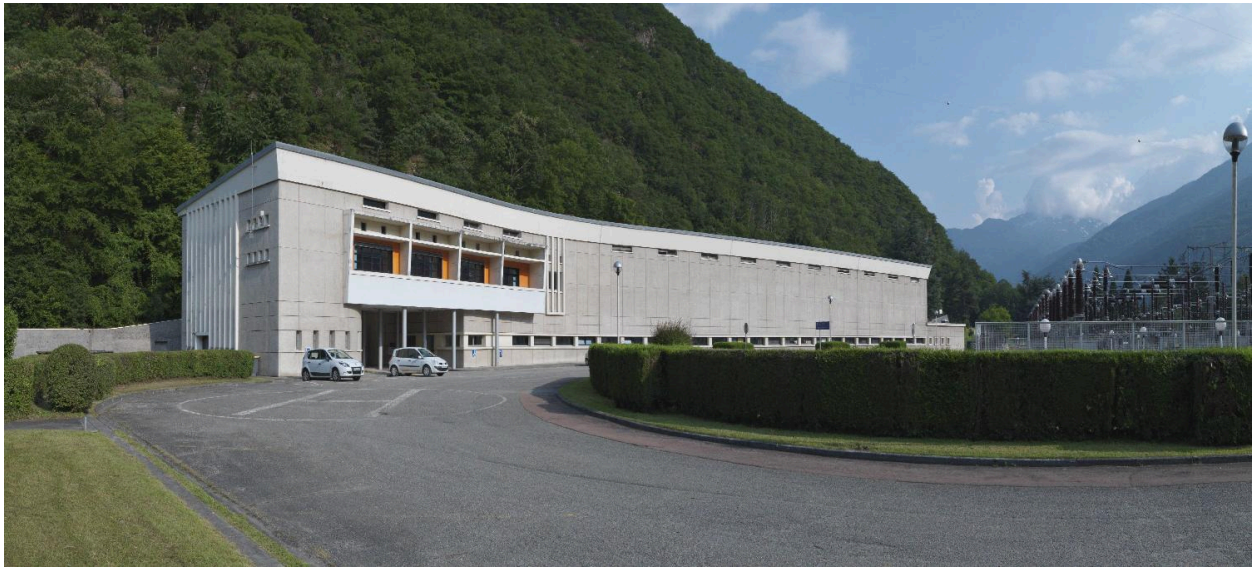
Vue d'ensemble de la centrale de la Bathie
