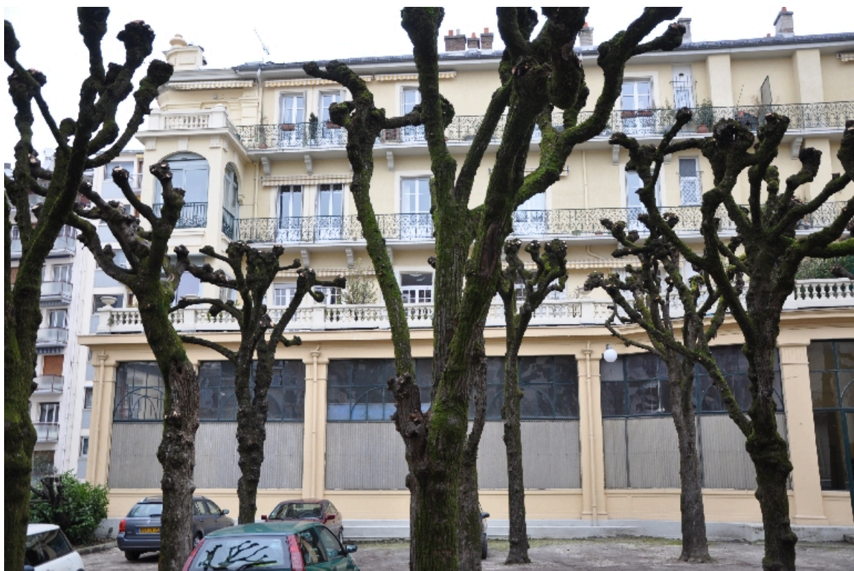
Aile N-W : détail de la façade sur cour
