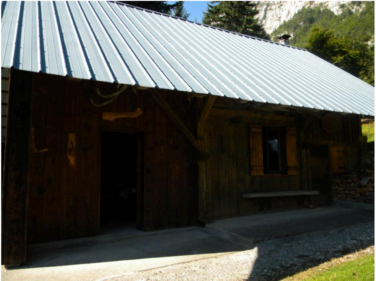
Vue d'un chalet modifié en habitation secondaire au Pleyu (2008 B5 624).
