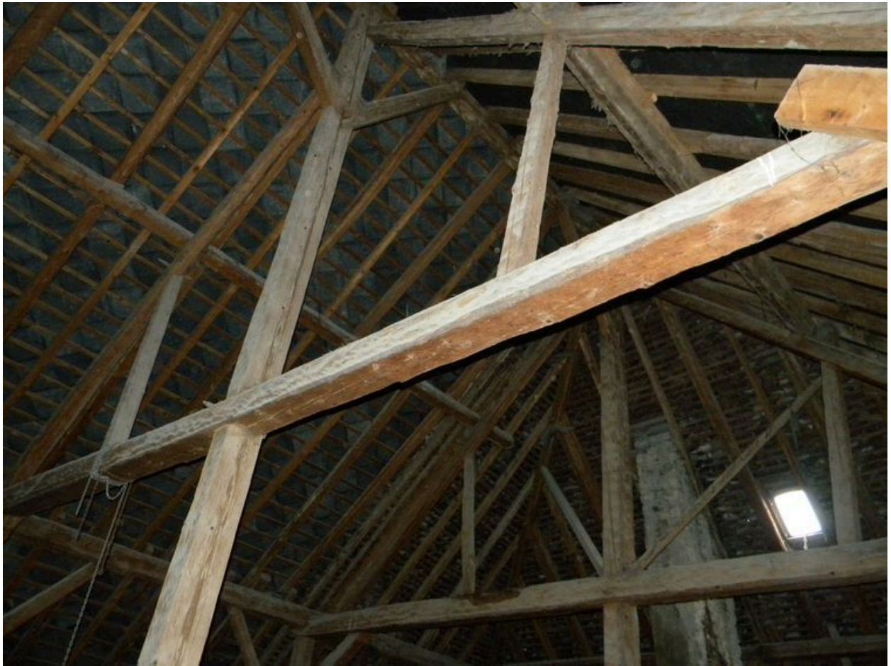
Vue de la charpente.
