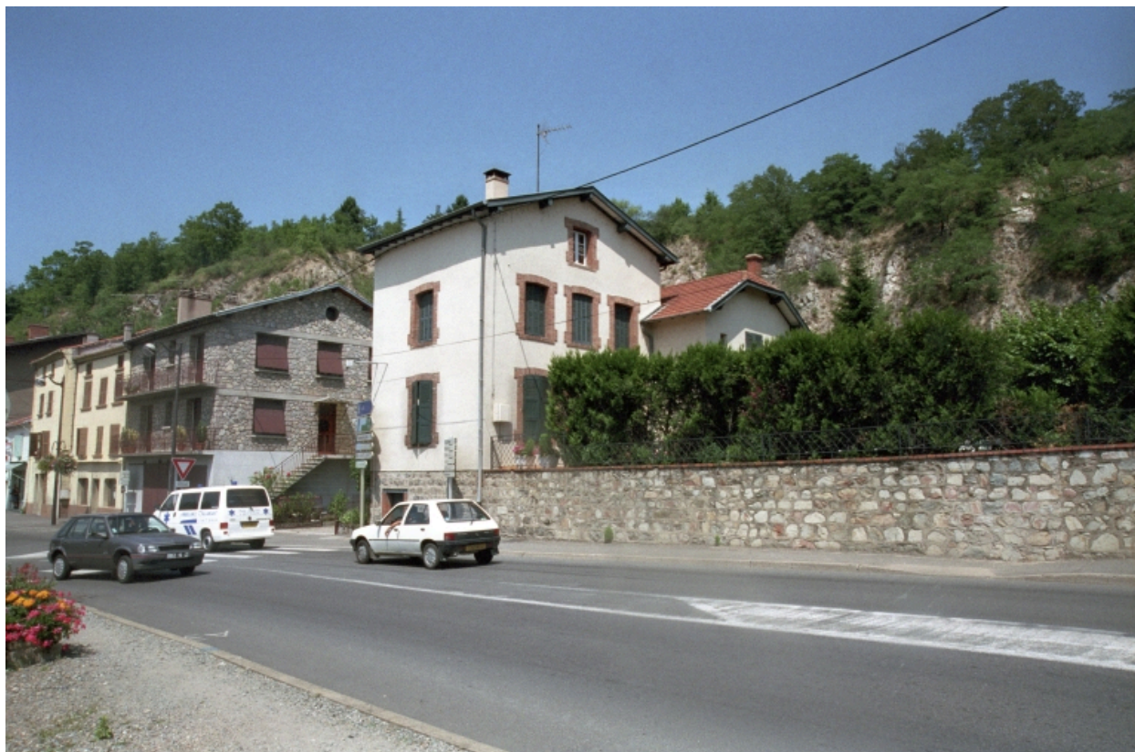
Boën, îlot 17, Lyon (rue de) 101. Vue générale de la façade sur rue.
